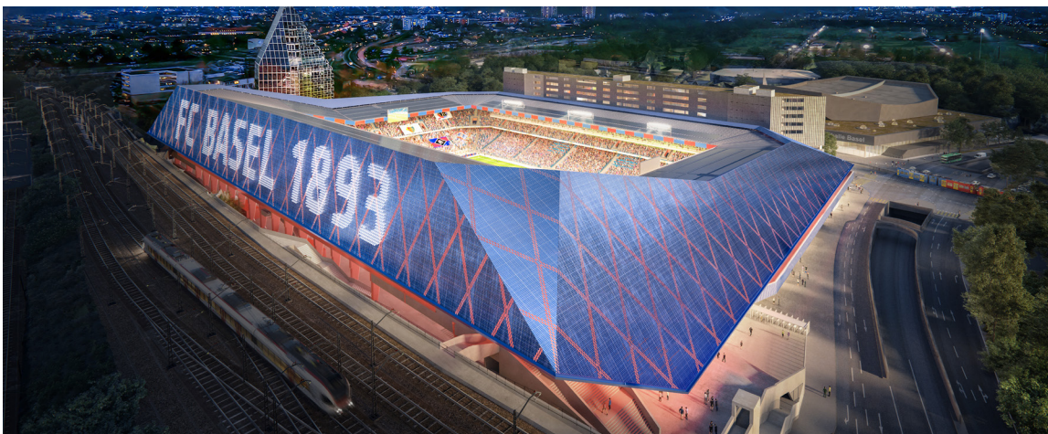
Die neue Gebäudehülle überdacht Plattformen, dient der Energiegewinnung und verleiht dem Stadion ein neues Gesicht.
